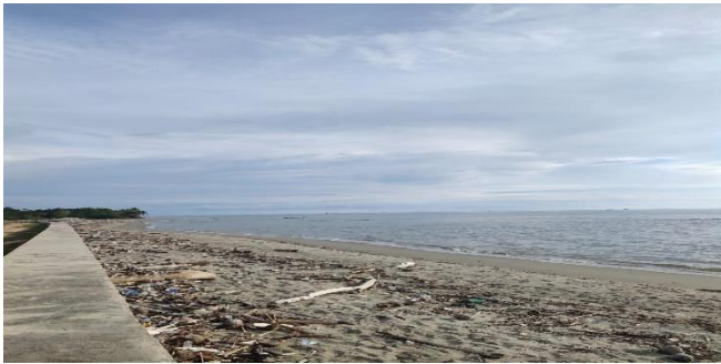
Gambar 3. Kondisi Eksisting Pantai Watubangga (Sumber : Survei Lapangan, 2021)
