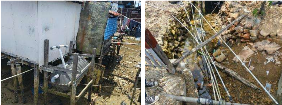
Gambar 3 Bak Penampungan dan Sistem Perpipaan di Desa Leppe
