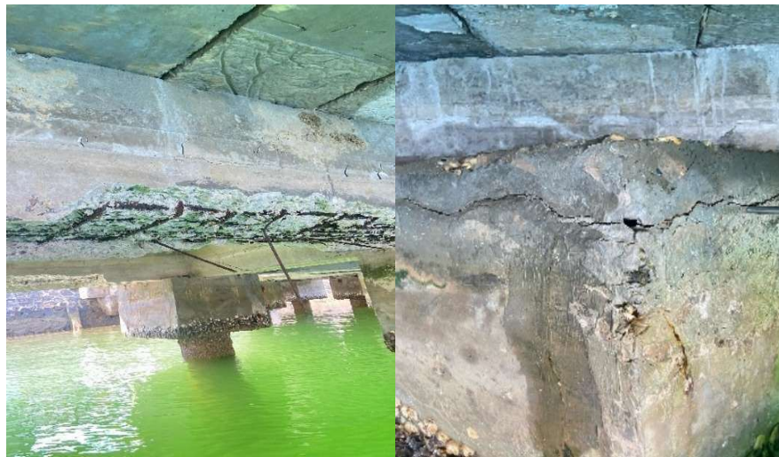
Gambar 2.1 Kondisi Struktur Dermaga (Sumber: Survey Lapangan, 2025)
