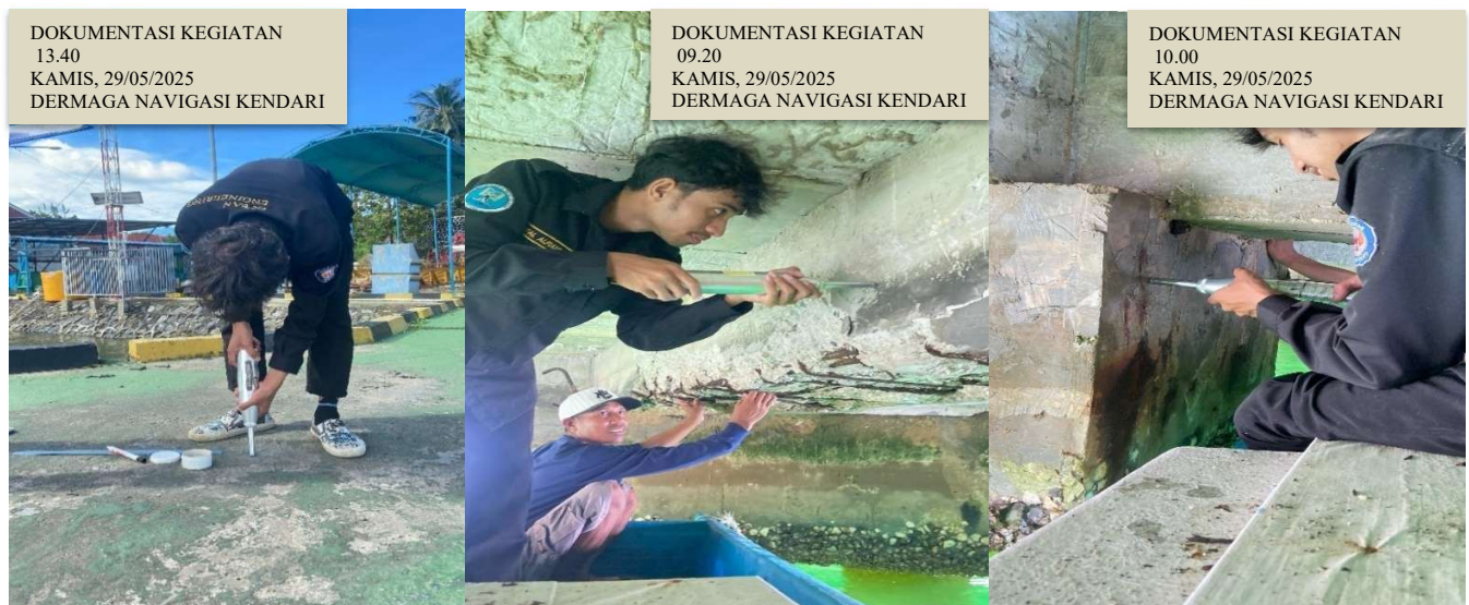
Gambar 3.3 Pengujian Hammer Test
